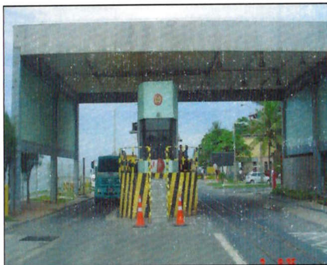
Figura 7.3 – Vista interna do Posto de Controle de Cargas – Entrada de Veículos.
