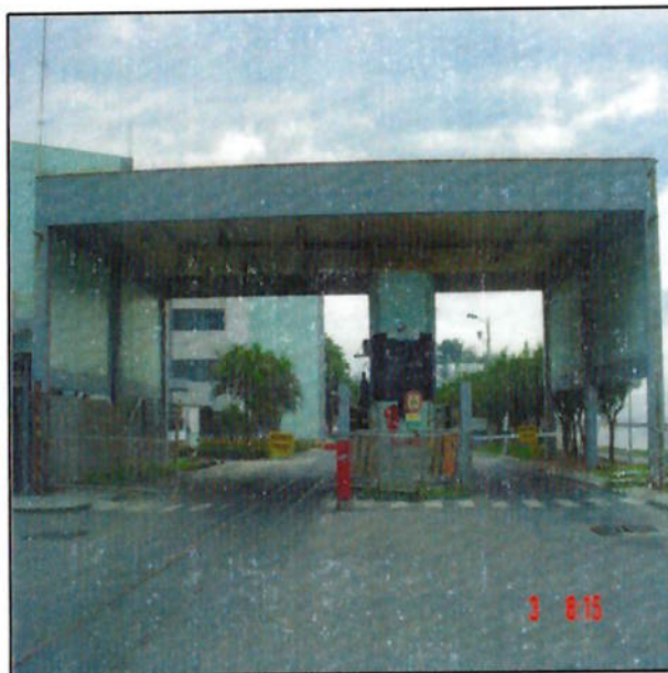
Figura 7.2 – Vista externa do Posto de Controle de Cargas, Imbetiba, Macaé - RJ.
